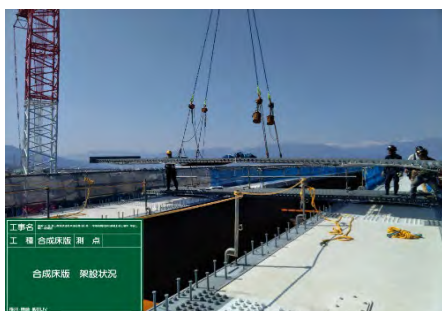
合成床版架設
