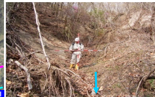
荒廃状況 写真①
