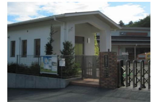
【写真②】要配慮者利用施設 (大野山保育園)
