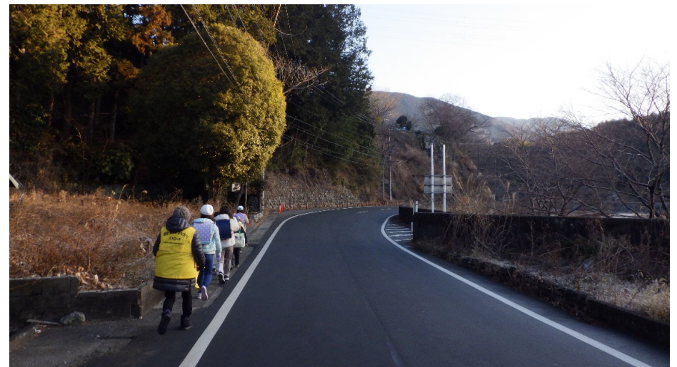
歩道幅員が確保されておらず、見通しも悪く危険な状態
