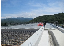
手すりがつきました!
