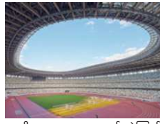
အမျိုးသားအားကစားကွင်း ပွဲကြည့်စင်ကို ကာမိုးပေးထားသည့် ကြီးမားသောအမိုးကြိုးအား ဒေသထွက် FSC လက်မှတ်ရကုန်ကြမ်း ( ဂျပန်ထင်းရှူး ) အား အသုံးပြုထားသည်။ ( ပုံပိုးမှု - ဂျပန်အားကစားမြှင့်တင်ရေးစင်တာ )
