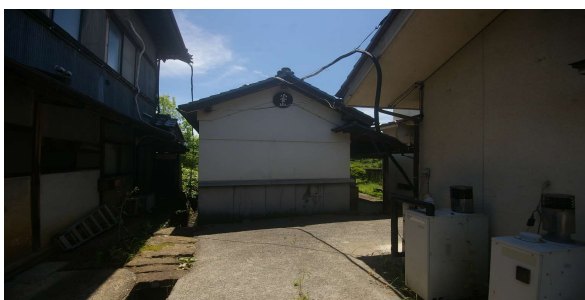
土蔵を北側から見る。
