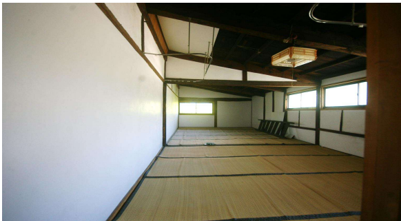
2階北側の2部屋、階段のある板の間から
