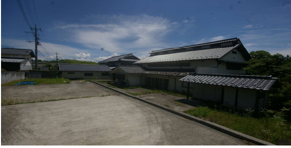
主屋を北西角から見る。
