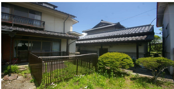
玄関外の南東にあるドッグランの囲いと古土蔵
