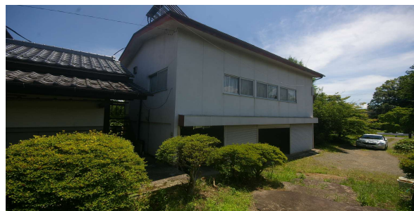
土蔵の南にある鉄骨造の倉庫
