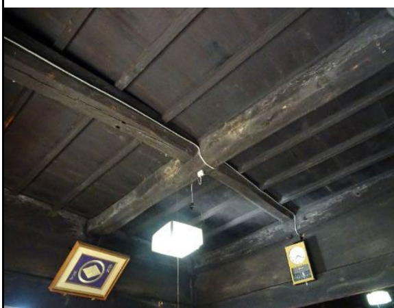
太い梁をあらわしにした根太天井 前座敷・居間も同様
