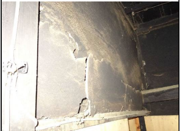
土間 北面土壁
