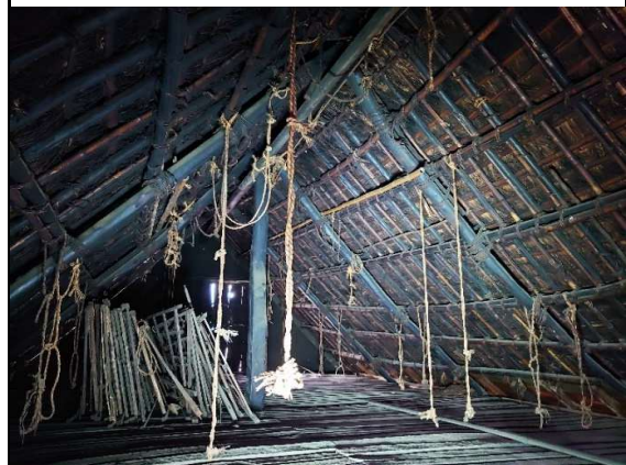
内観 3階(小屋裏) 移築時は茅葺き下地撤去処分推奨
