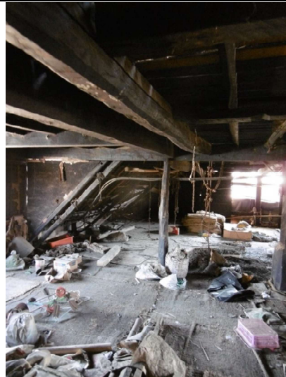
内観 3階(小屋裏) 移築時は茅葺き下地撤去処分推奨
