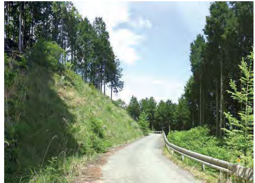
② 林道の整備済区間と周辺の森林状況
