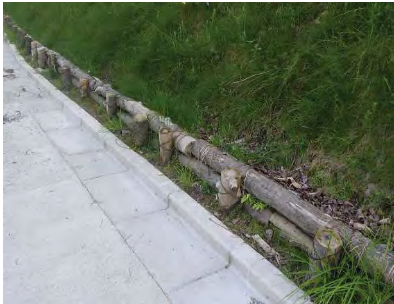
⑦ 現地支障木を利用した丸太柵工
