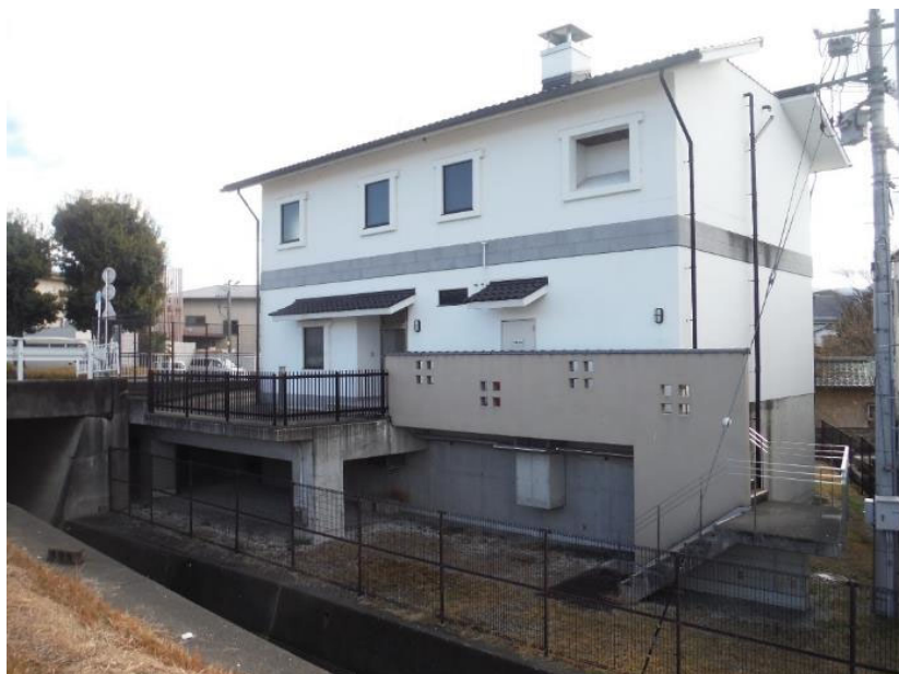
金川中継ポンプ場
