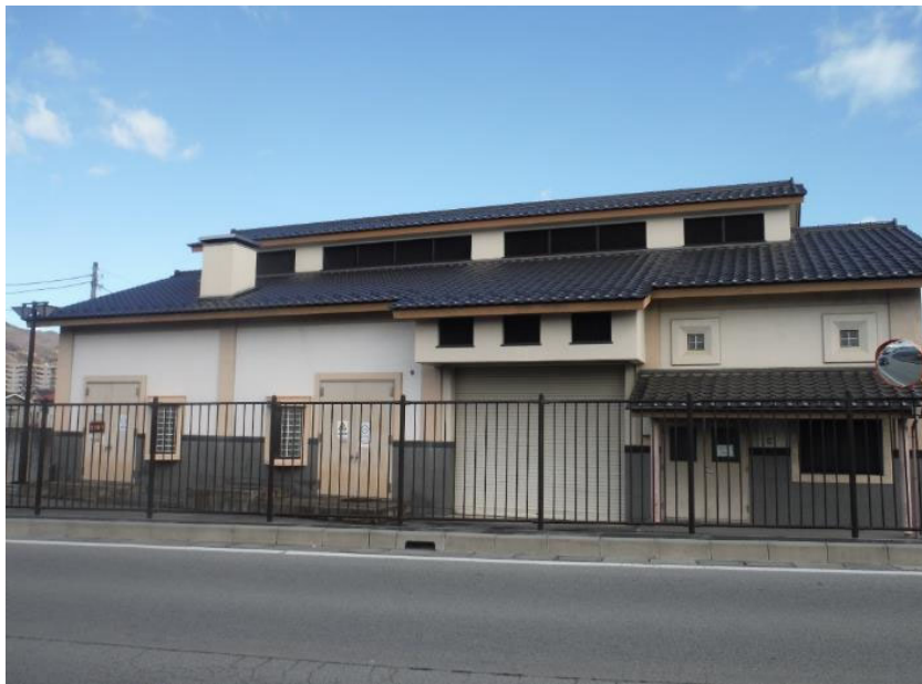
日川中継ポンプ場
