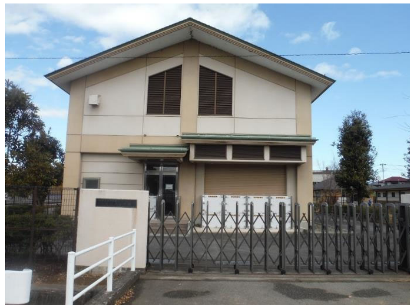
浅川中継ポンプ場
