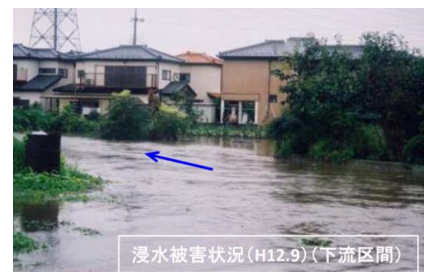
平成12年9月豪雨浸水被害状況
