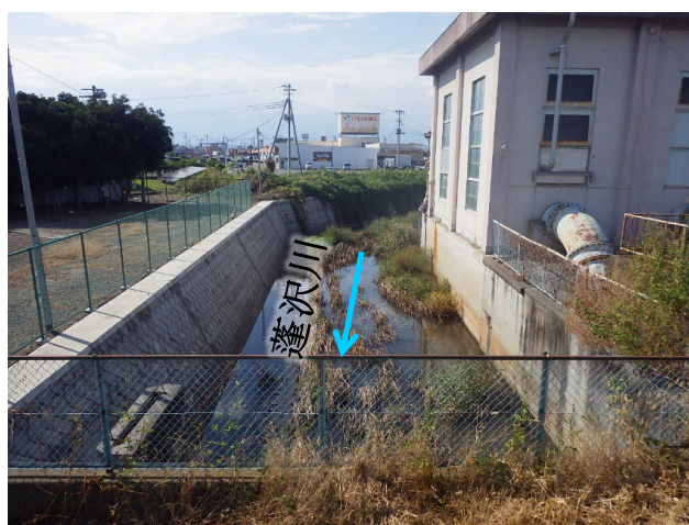
図 3-4 玉諸右岸排水機場
