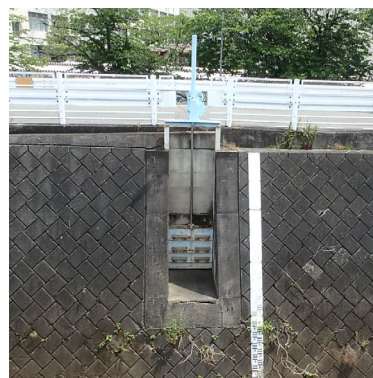
大円川第 6 排水樋門
