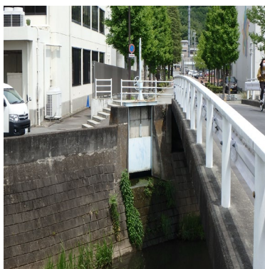
十郎川第 2 排水樋門
