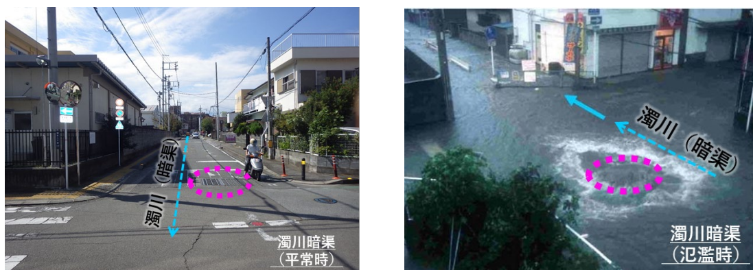
図 3-14 濁川の被災状況 (平成 16 年 8 月洪水)
