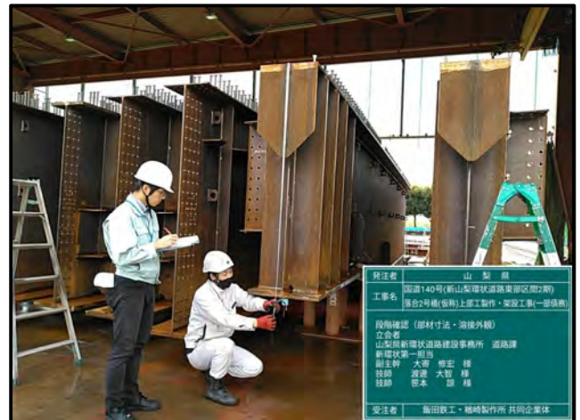
橋桁製作状況
