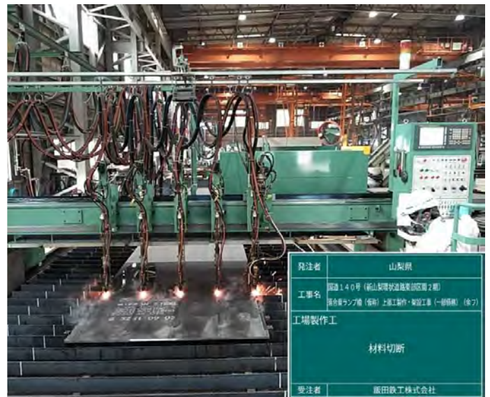
橋桁切断状況
