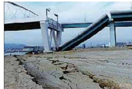
阪神淡路大震災での被害
