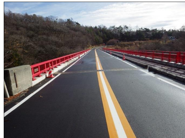
修繕工事の完成
