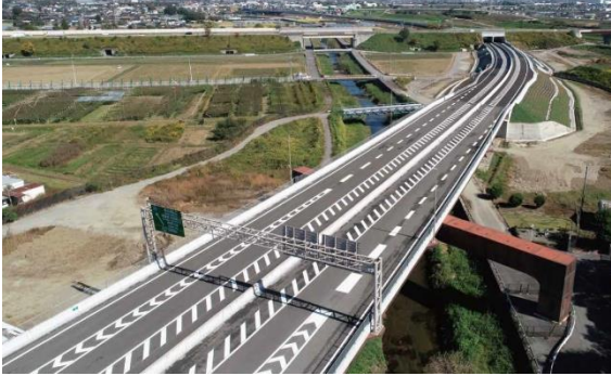
新山梨環状道路東部区間 穂池大橋
