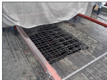
悪いコンクリートを取り壊して
