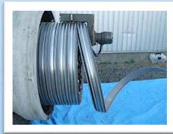
プラスチック材による既存管路の内面被覆
