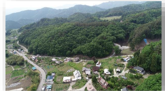
砂防堰堤 中の入沢 (甲州市)
