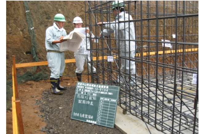
ファームポンド配筋検査
