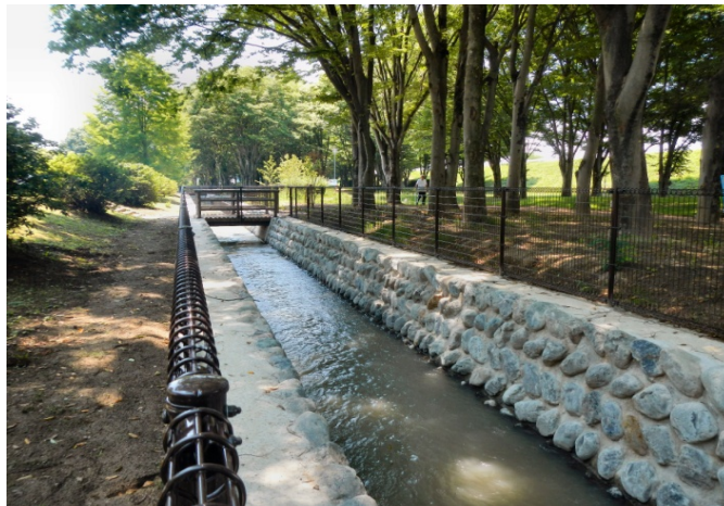
用・排水路整備
