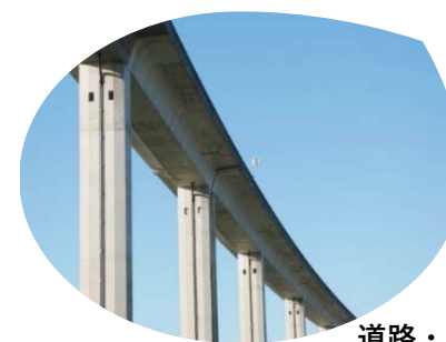
道路・トンネル
