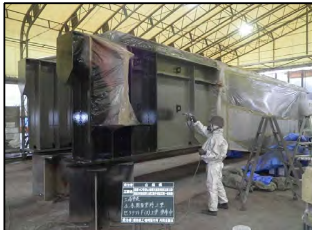
橋桁製作状況
