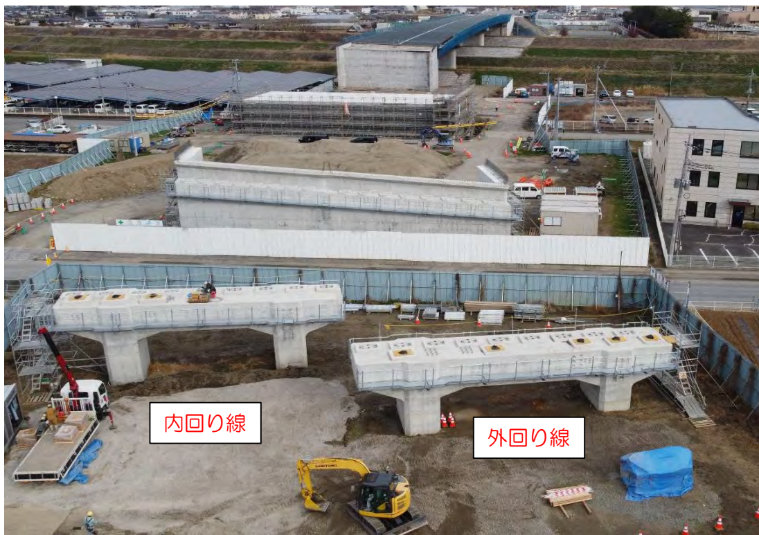
【現場全景（上空より）】
