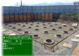
鋼管杭完了
