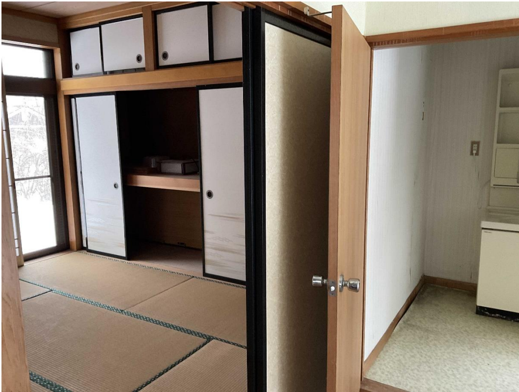
⑪ 建物1階 北側 和室・洗面所
