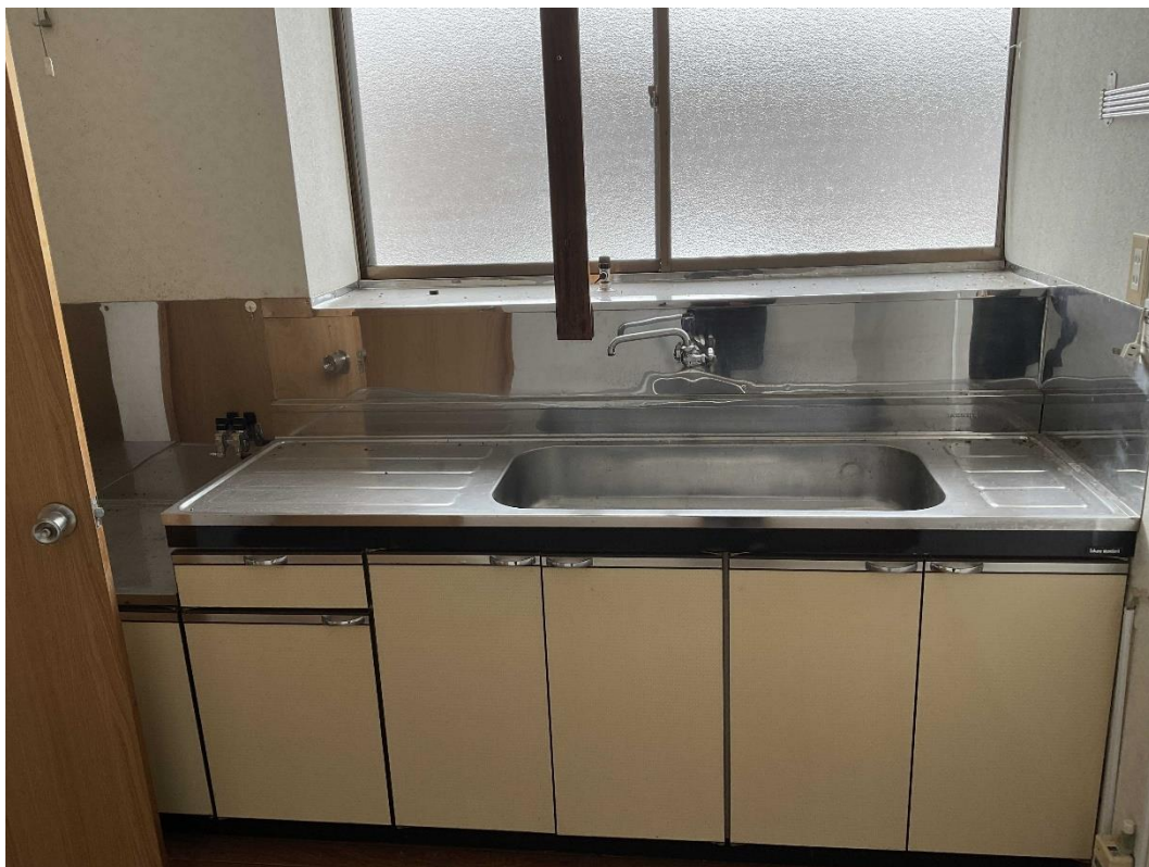
③ 建物1階 南側 台所
