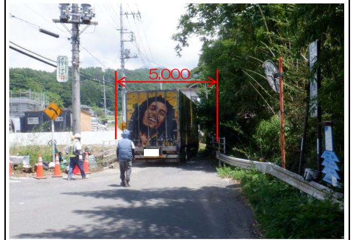
道路幅員が狭く、すれ違いが困難な状況
