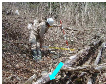
荒廃状況 写真①
