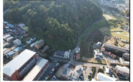
②斜面状況(全景)
