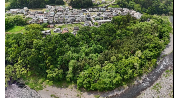
②斜面状況(全景)
