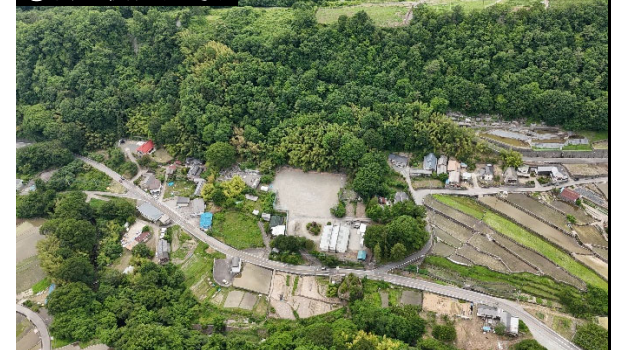
②斜面状況(全景)
