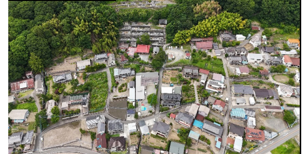
②斜面状況(全景)
