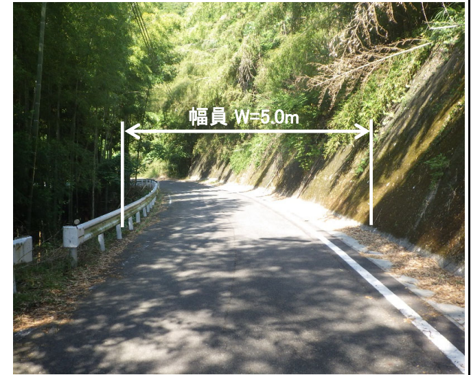
終点側から起点側を望む
