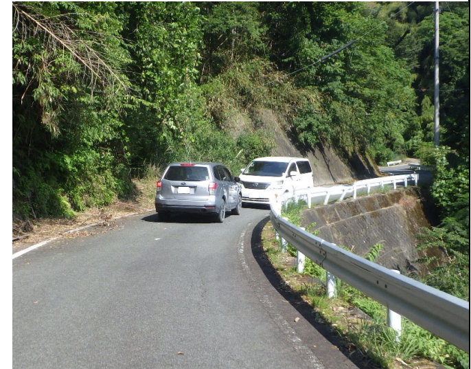
幅員が狭くすれ違いが危険な状況
