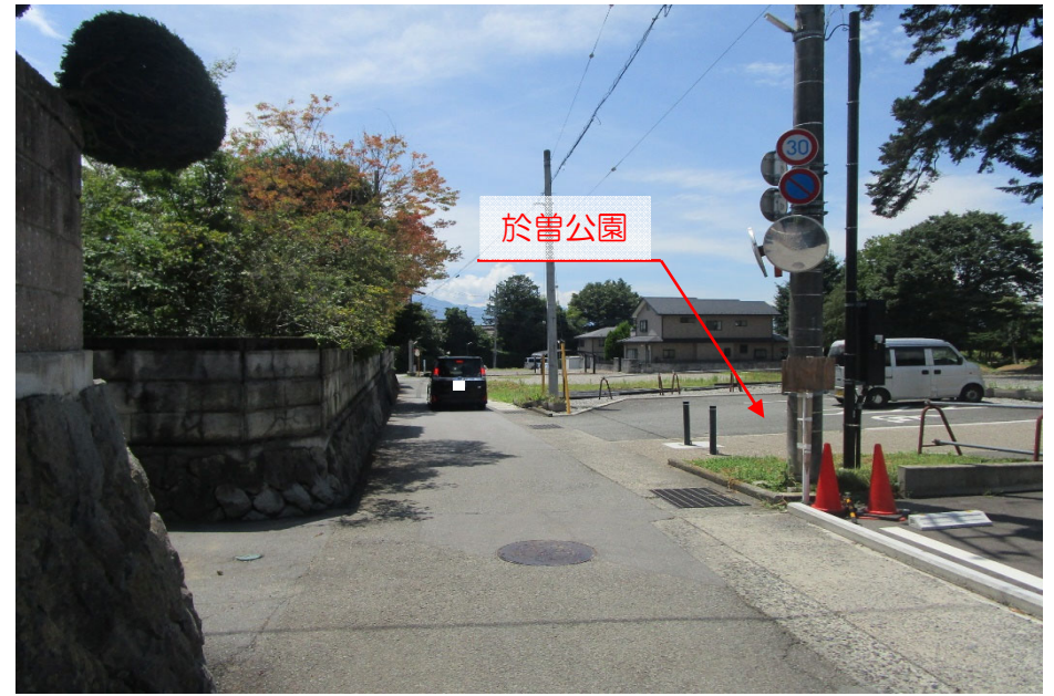
③指定避難場所である於曽公園前の狭隘な道路の状況
