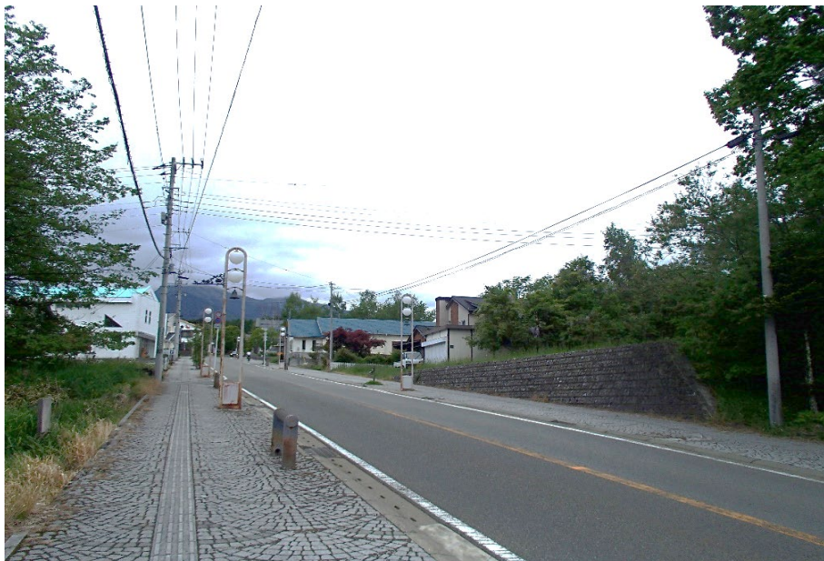
【写真②】 景観を阻害する電線類
