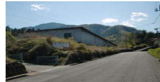
② 保全対象(県道 高畑谷村停車場線)
