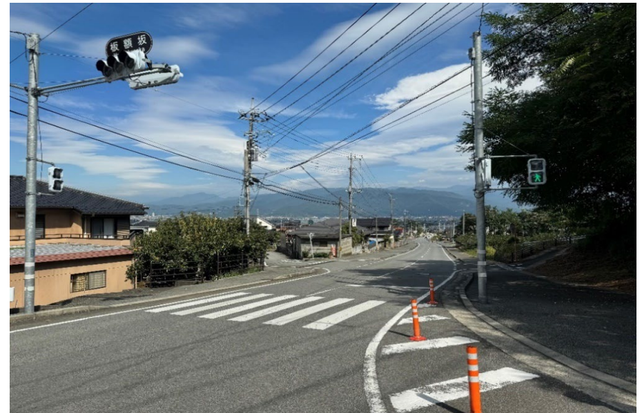
【写真②】 災害時の電柱の倒壊により緊急輸送道路の機能が発揮できない恐れ
