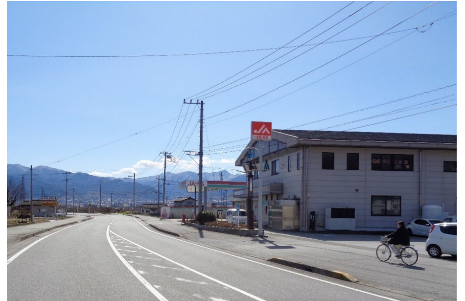
【写真②】 災害時の電柱の倒壊により緊急輸送道路の機能が発揮できない恐れ
