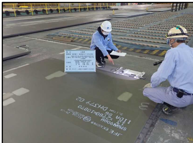
施工状況(鋼材検査)
