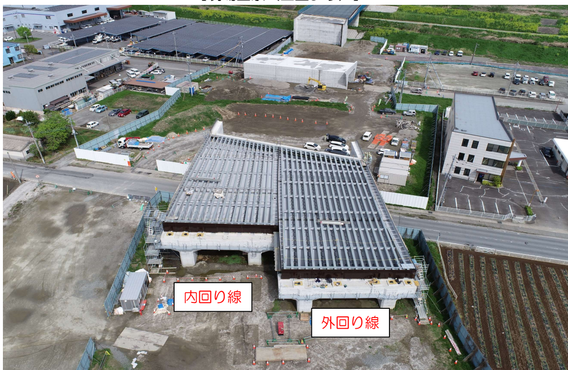
【現場全景（上空より）】
