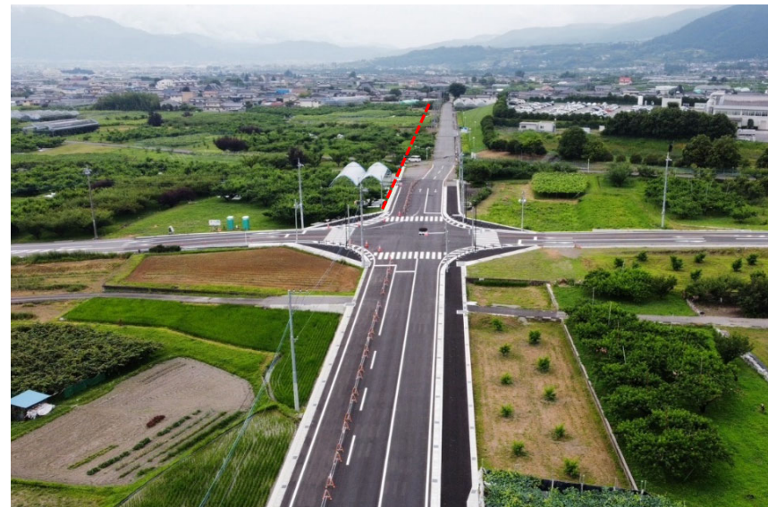
② 徳島下交差点から飯野一区交差点（南方面）を望む
