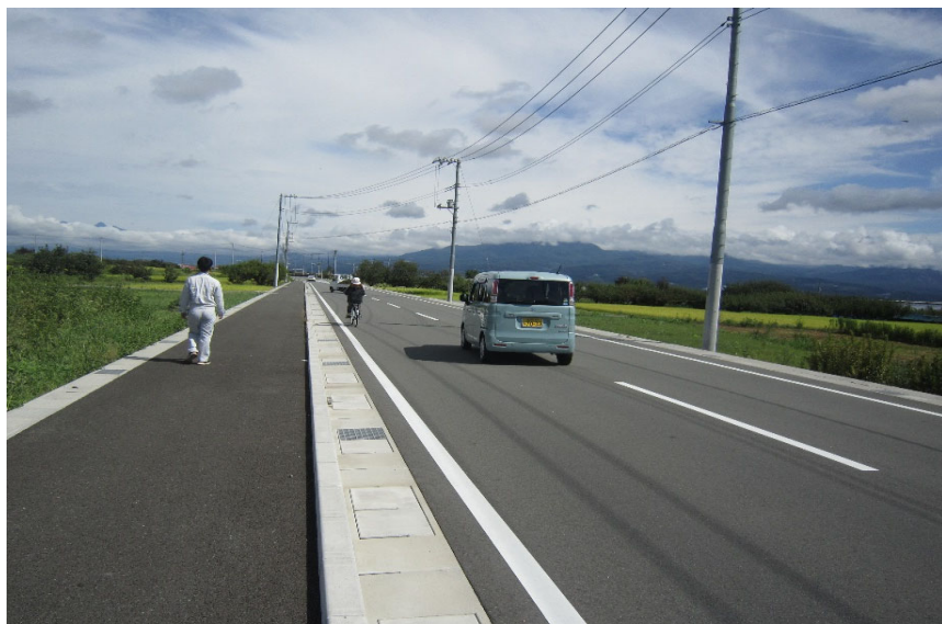
③ 完成区間の状況（2車線・歩道あり）
