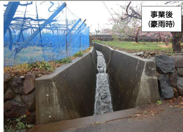
水路の整備により台風や豪雨時においても雨水が適正に排水されるようになり、溢水被害が解消され、果樹の品質が向上するとともに、維持管理の労力が軽減された。
