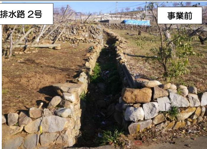
老朽化による石積みの一部崩落及び水路の断面不足により溢水が生じ、補修などの維持管理にも多大な労力を費やすとともに、果樹の生育不良の原因となっていた。
