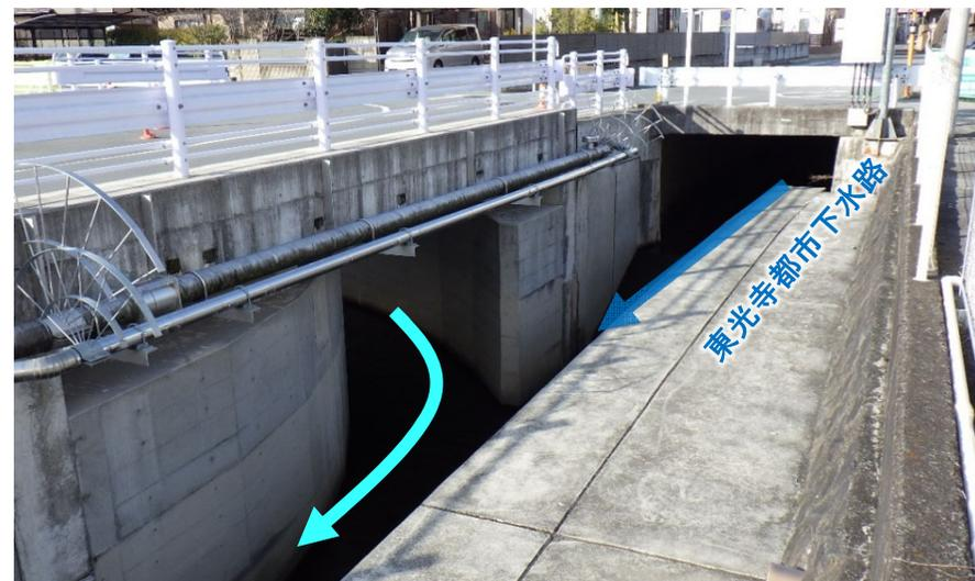
東光寺都市下水道と屈曲して合流していた形状を滑らかな合流する形式に改良
