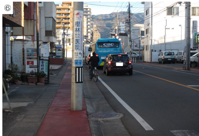
歩道を妨げる電柱
