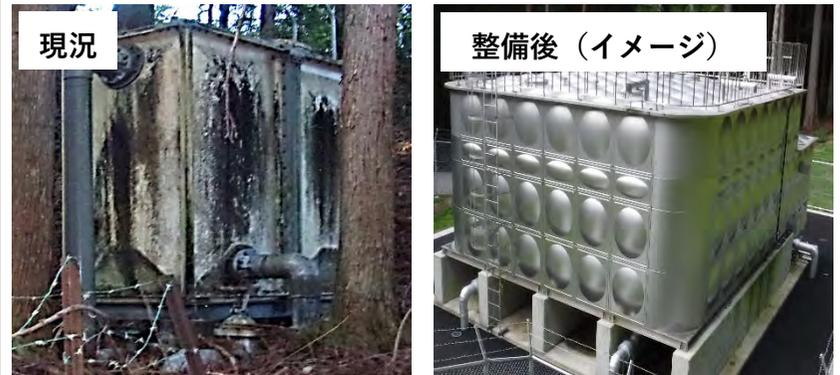
簡易水道の老朽化により、今後の安定した営農飲雑用水の供給が危ぶまれる状況である。そのため、導水管、貯水槽の改修を行い、機能改善を図る。
