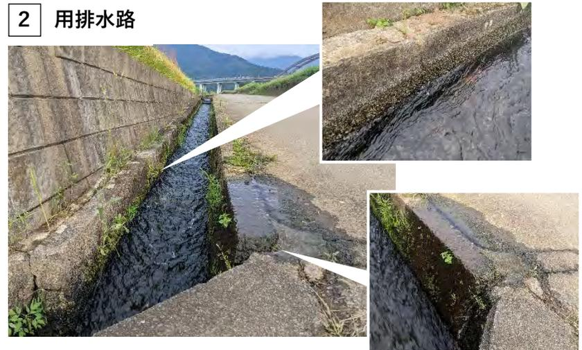
水路の経年劣化の影響で、漏水が発生し水路補修などの維持管理に苦慮している。
