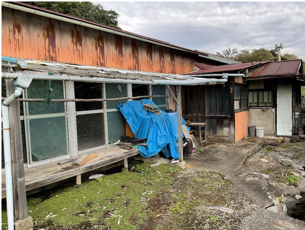
建物を南側から撮影
