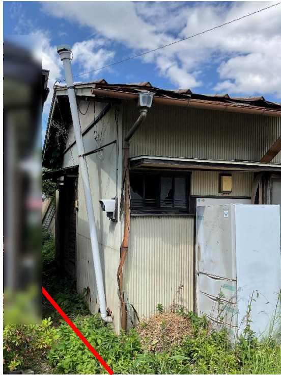
対象物件西側側面を撮影（赤線は隣地とのおおよその境界）
