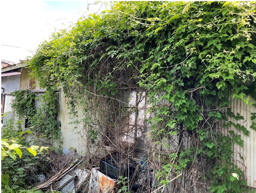
建物全体を北東側から撮影（家屋番号634番4の1）
