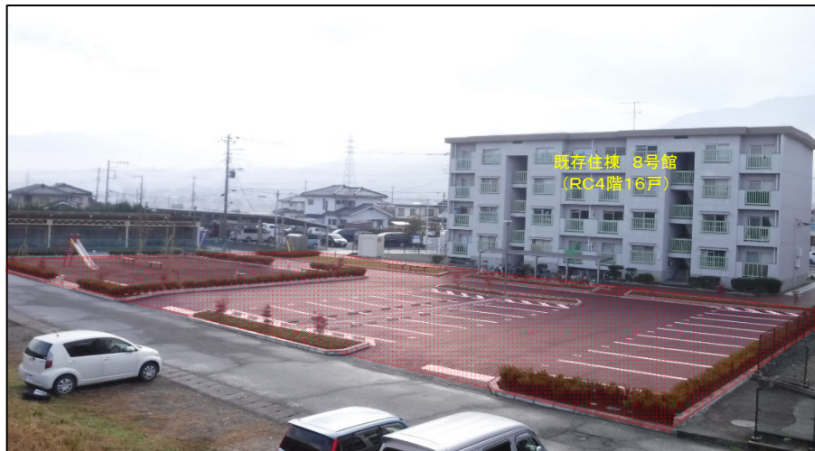
完成状況 (広場及び児童遊園・透水性舗装)
