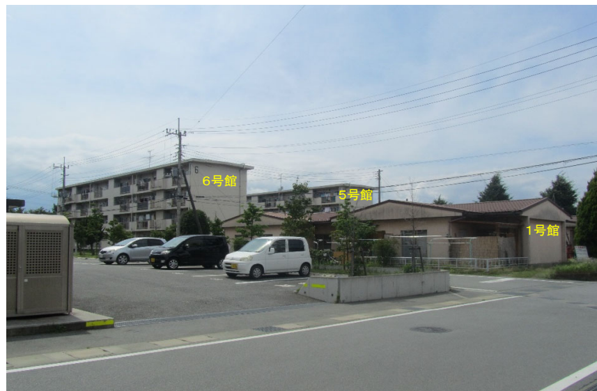
解体棟 1号館・5号館・6号館 外観 南東側より
