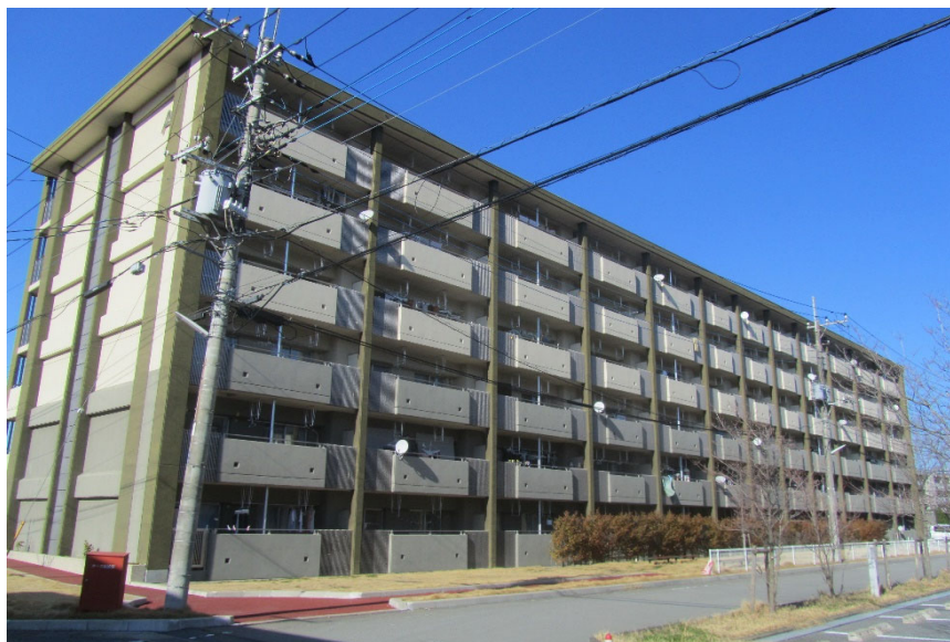
新A号棟 外観 南西側より
