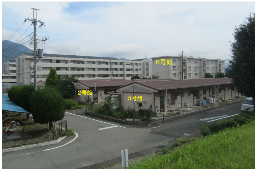
解体棟 2号館・3号館・6号館 外観 北東側より
