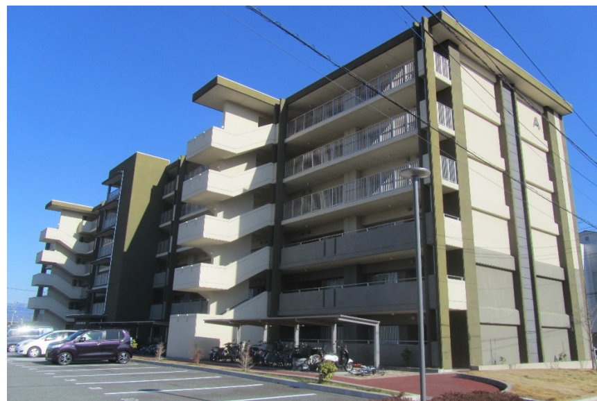
新A号棟 外観 北西側より
