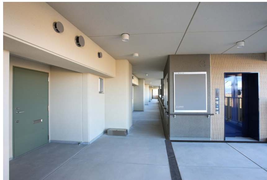
新A号棟 1階廊下
