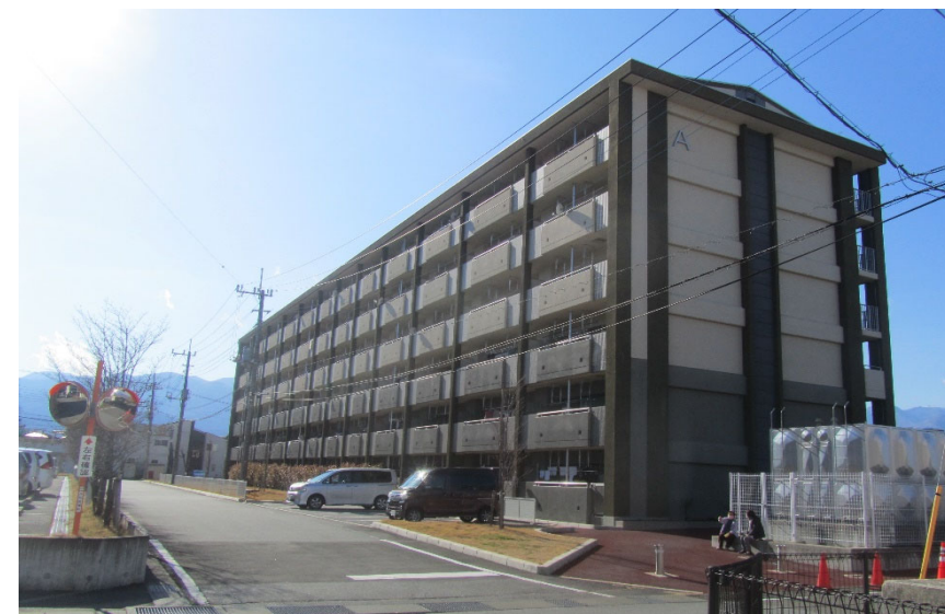
新A号棟 外観 南東側より
