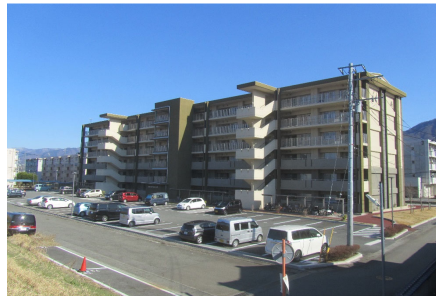
駐車場(透水性舗装)
