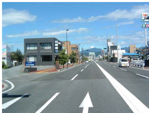
電線類地中化(後)(国道358号)
