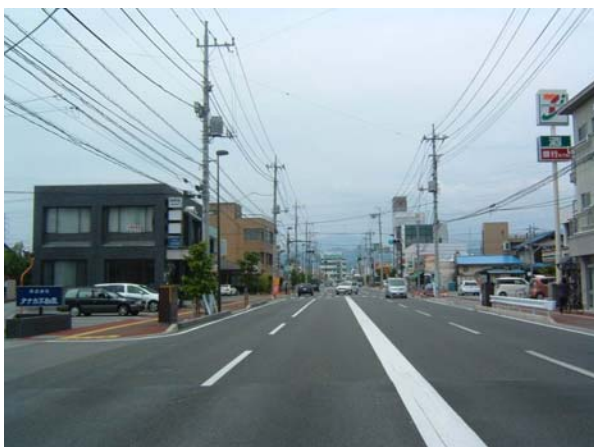
電線類地中化(前)(国道358号) (写真：2.17)
