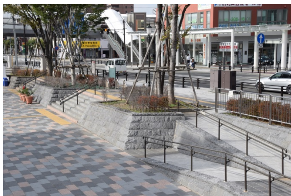
スロープ、点字ブロック、2段手すりを取り入れた広場の整備 (甲府駅北口)
