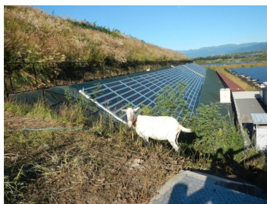
自然エネルギーを使った太陽光発電 環境に配慮した動物による除草 (甲府市 米倉山メガソーラー) (写真：2.26)
