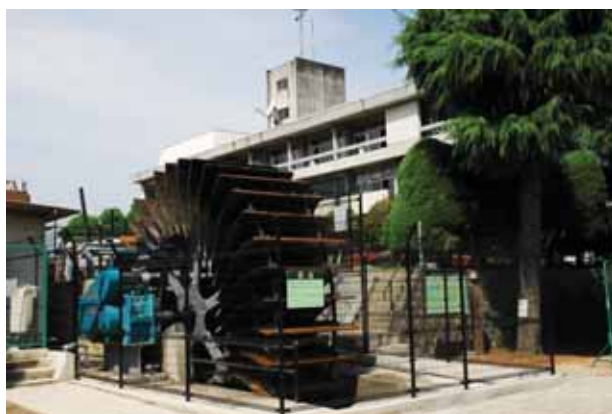
自然エネルギーを使った水力発電 (都留市 元気くん1号) (写真：2.25)
