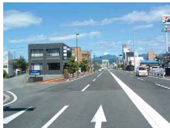
電線類地中化（後）（国道358号）
