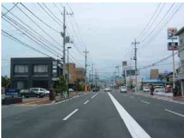
電線類地中化（前）（国道358号） (写真：2.17)
