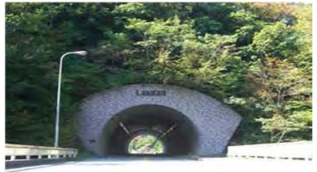
写真 4.1.90 面壁型坑口部
