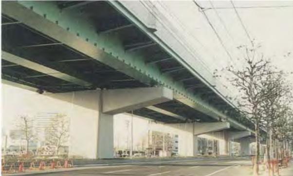
写真 4.1.84 柱に梁を設けた形
