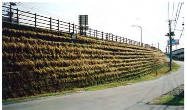
写真 4.1.75 壁面材による緑化
