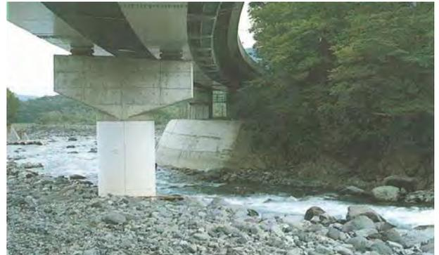
写真 4.1.86 地形改変を回避し、谷側に振り出した例
