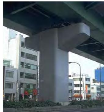
写真 4.1.141 柱と梁を明確に区分した橋脚
