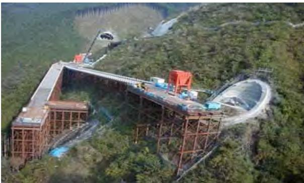
写真 4.1.87 竹割型構造物掘削
