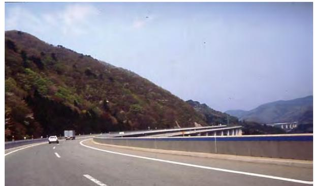
写真 4.1.66 高架構造による地形改変の軽減
