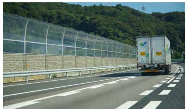
写真 4.1.123 遮音壁の上部パネルに透光板を採用している例
