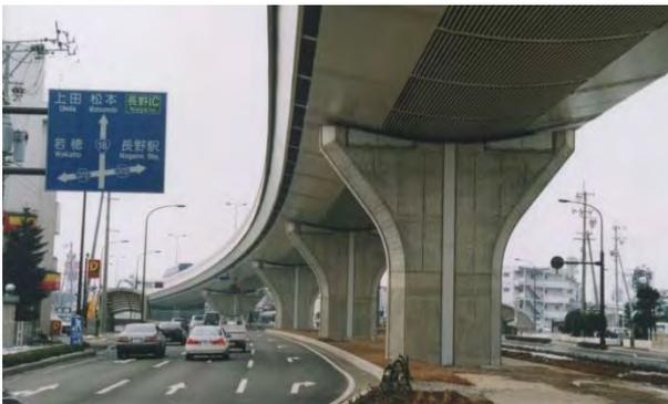
写真 4.1.140 張り出し部の追加施工を考慮した暫定形
