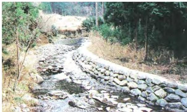
写真 4.2.63 天端コンクリートが目立つ例
