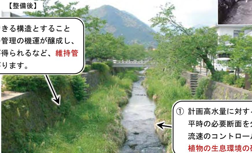
① 計画高水量に対する必要断面に対して平時の必要断面を分ける複断面により流速のコントロールが可能となり、**動植物の生息環境の確保**に繋がります。
