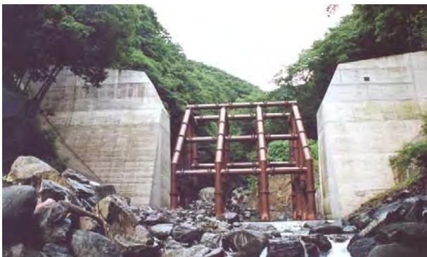
写真 4.3.30 透過性をもたせた形状、周辺調和した色彩選定鋼管を立体状に結合することで、透過部に一体感を持たせ安定感を与えている。その上で、溪流の連続性を確保している。
