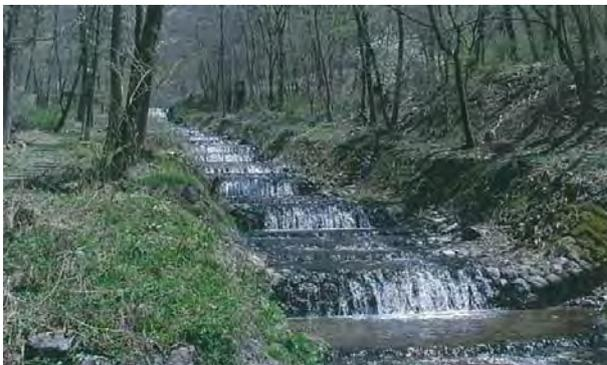
写真 4.3.9 床固・張石水路・護岸が一体化したデザイン
