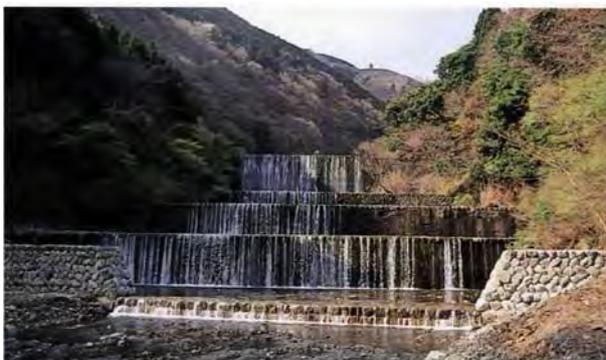
写真 4.3.5 小規模施設の複数基設置
