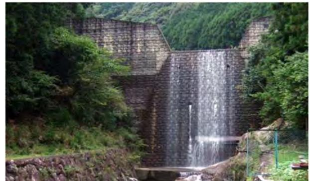
写真 4.3.35 コンクリート表面のエイジング
