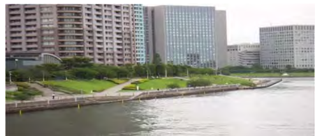
写真 4. 4. 49 河川で整備された緩傾斜護岸の上に整備された公園 住棟まわりの緑地とも一体的に整備されている。 ※参考文献 4-4-3 より (東京・区立石川島公園)
