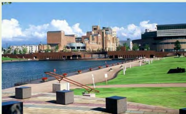
写真 4. 4. 17 公園と調和のとれた周辺施設
