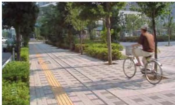
写真 4. 4. 62 同じ舗装材料を使って一体性を確保した公園と道路との境界処理の例
