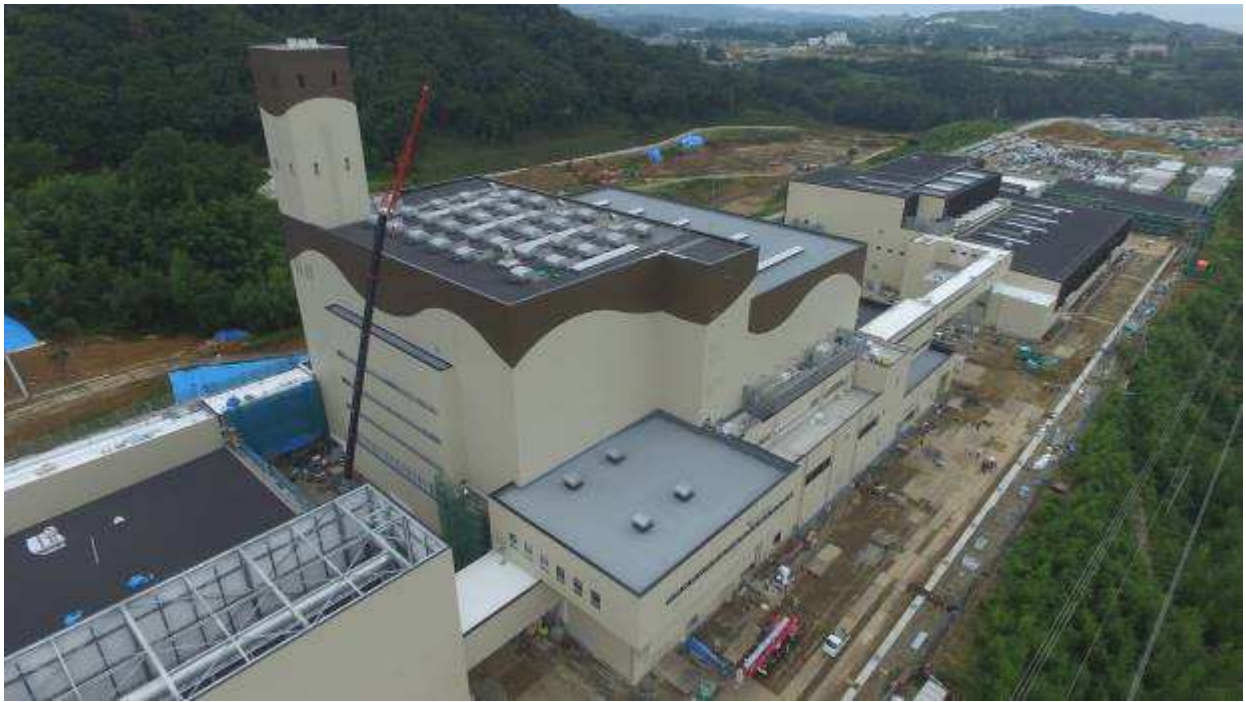
図 2-2-17(5) ごみ処理施設の工事实施状況（焼却溶融施設 北東側視点） 平成 28 年 9 月時点
