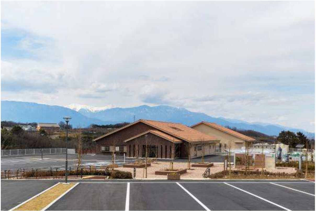
図 2-2-2(6) 完成写真（地域振興施設：平成 30 年 11 月撮影）
