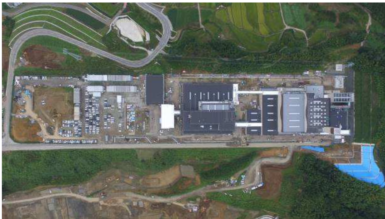
図 2-2-17(1) ごみ処理施設の工事实施状況（全体 上空視点） 平成 28 年 9 月時点
