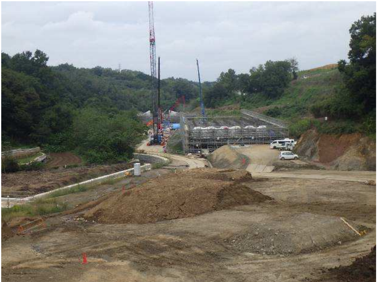
図 2-2-18(1) 最終処分場の工事实施状況（浸出水調整池及び防災調整池） 平成 28 年 9 月時点
