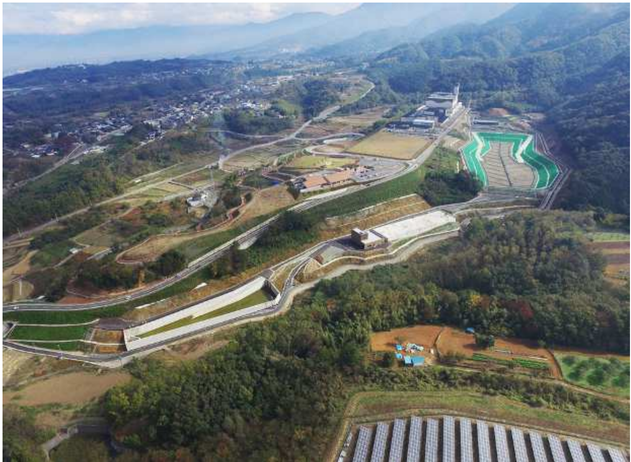
図 2-2-2(5) 完成写真（最終処分場：平成 30 年 11 月撮影）
