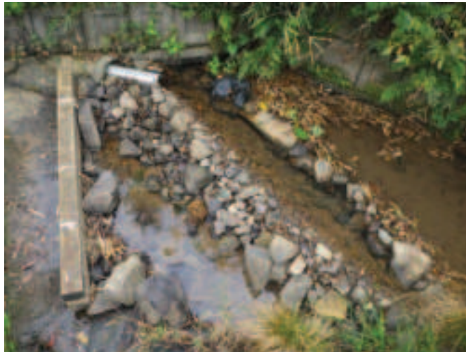
写真 5.10-8 整備された下流側ビオトープの取水口（2021年10月24日撮影）
