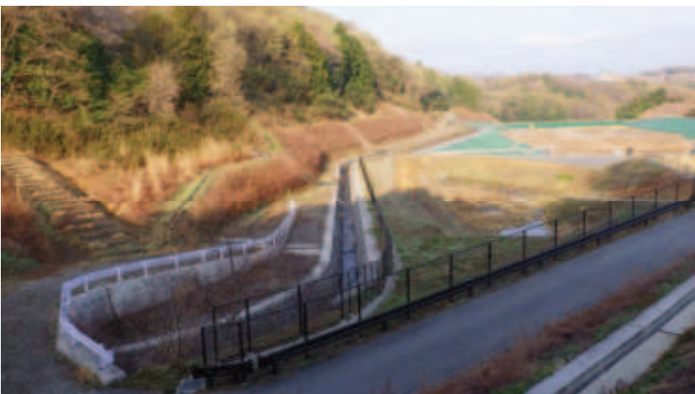
写真 5.10-3 蟹沢川付替区間の状況（令和4年4月7日撮影）
