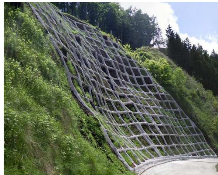
簡易法枠工の完成状況
