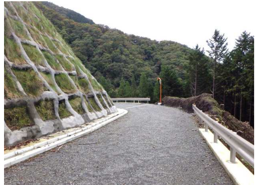
② 林道の整備済み区間の状況
