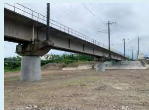
④・⑤耐震補強工
