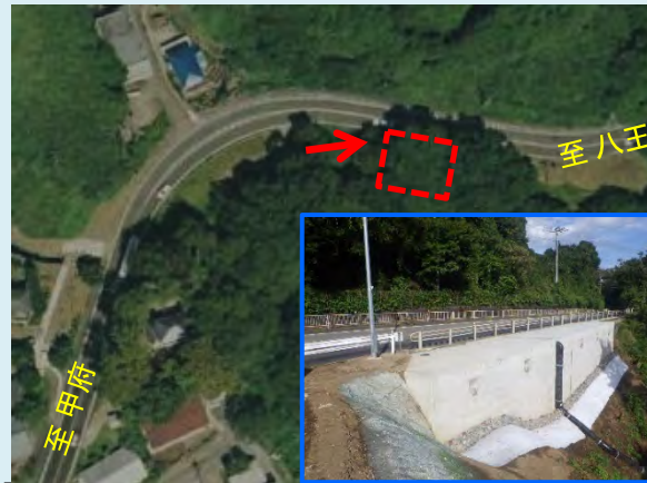
② 【R3補正対策工事】山梨県上野原市四方津地先 【防災対策】場所打法枠工等→R5.10完成
