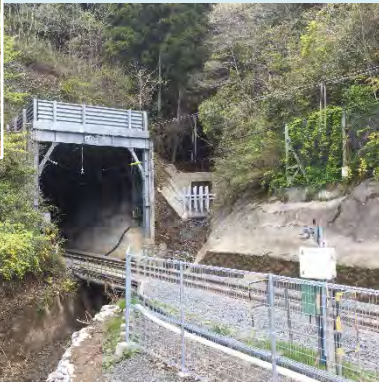
①しゅん濇・土砂止めスクリーン復旧
