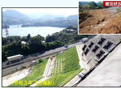
写真：中央自動車道 与瀬地区の復旧作業完了状況
