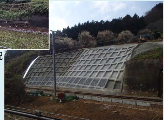
③吹付格子砕工・排水設備整備
