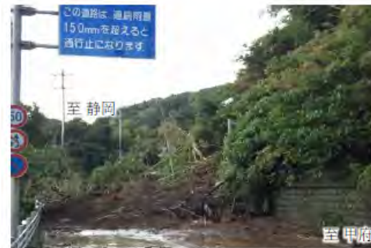
▲写真① 国道52号規制区間内の被災状況 (古屋敷地区) (令和元年10月)
