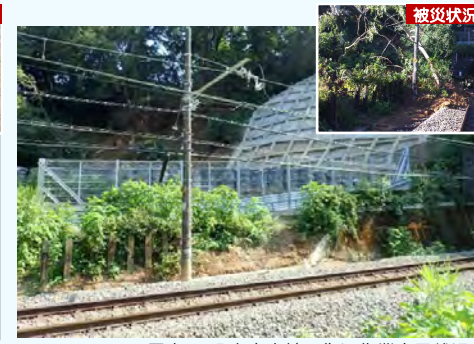
写真：JR中央本線の復旧作業完了状況
