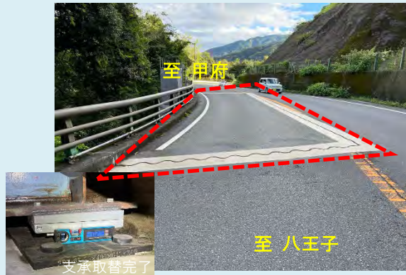
① だいちさんどう 第2棧道橋 【橋梁補修】主桁補修、支承補修等
