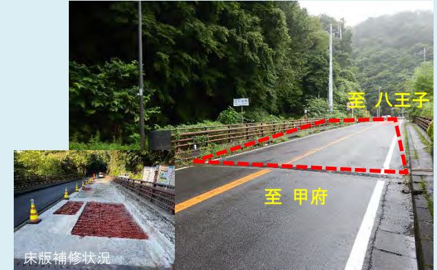
③ おおたるみ 大垂水橋 【橋梁補修】主桁補修、床版補修等
