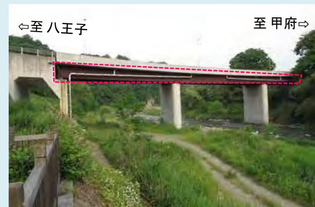
つるかわ ③ 鶴川橋 (R6完了予定) 【橋梁補修】 構造物補修等
