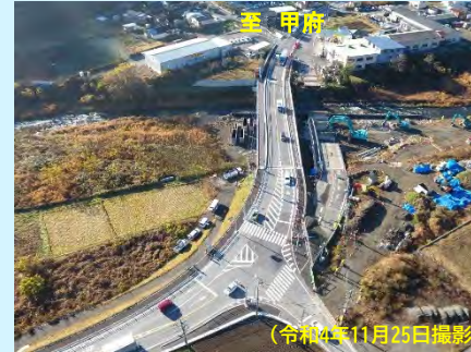
国道20号法雲寺橋新設橋の供用後 (令和4年11月25日撮影)
