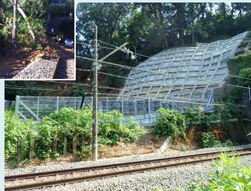
②吹付格子砕工・土砂止め柵設置
