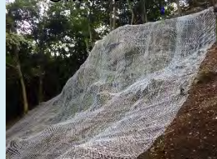
③落石対策工
