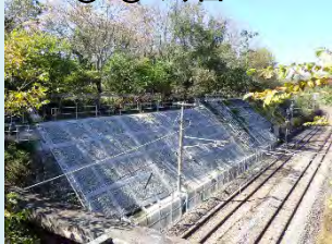
①・②のり面工
