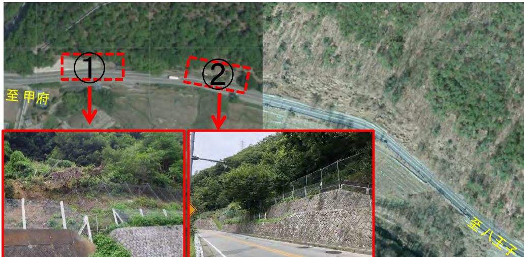
①②【R6補正対策工事】山梨県甲州市大和町初鹿野地先 【防災対策】高エネ吸収柵/既設防護柵の高上げ
