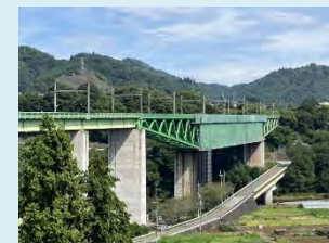
⑥塗装塗替え(上段)・⑦倒竹対策(中段)・⑧目地修繕(下段)
