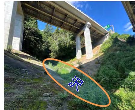
急峻な谷地形にて工事用進入路を整備中 写真：2024年6月
