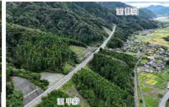
▲写真② 中部横断自動車道 (令和5年9月)
