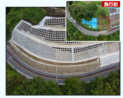
写真：国道413号道路災害防除工事の施工後
