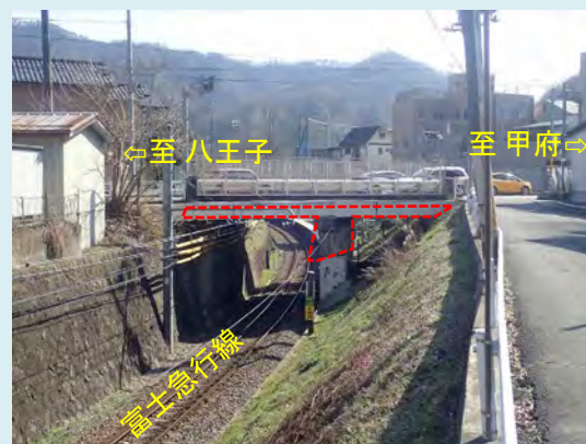
てんのう ② 天王橋 (R6完了予定) 【橋梁補修】 主桁補修、橋脚補修等
