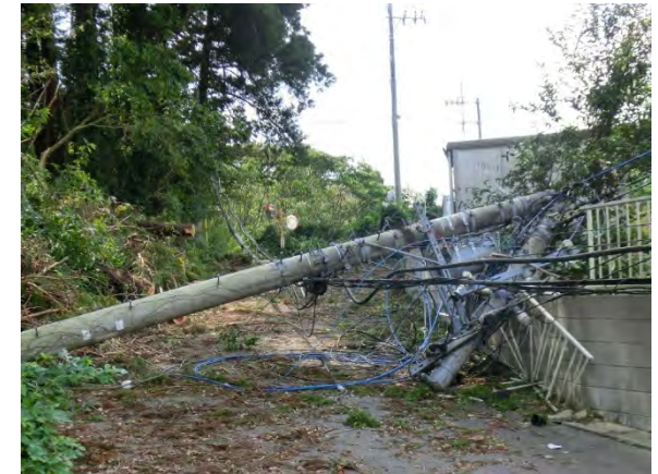
令和元年9月 千葉県山武市 山武市道
