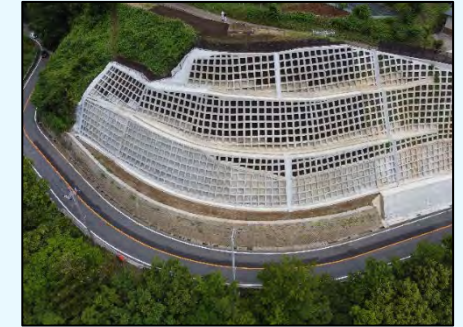
国道413号道路災害防除工事の施工後
